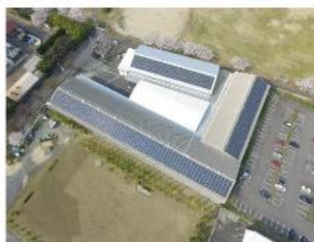
野洲川太陽光発電所
